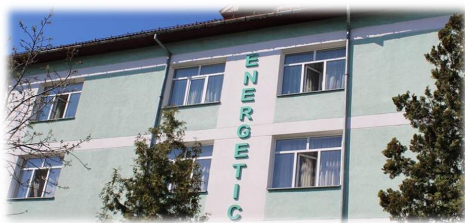
Fig. 2.100. Imagine cu Liceul energetic din TgJiu unde au fost amplasate panouri fotovoltaice
